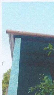
Foto 2: Sustitución de canales en mal estado.
