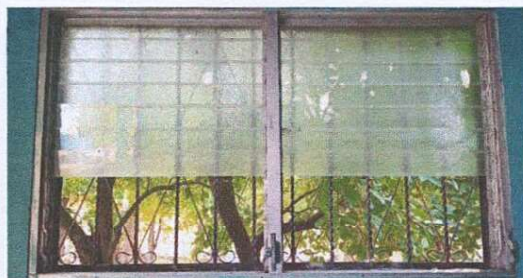
Foto 4: Reparación de ventanas de PVC.
