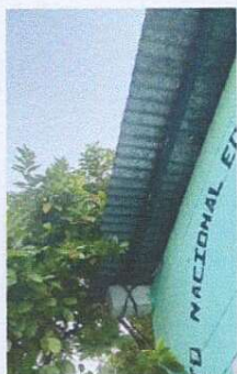
Foto 1: Sustitución de lámina, por lámina troquelada calibre 26.
