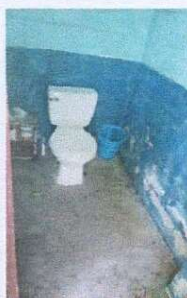
Foto 3: Mantenimiento de baños, pintura, limpieza y mantenimiento de puertas.
